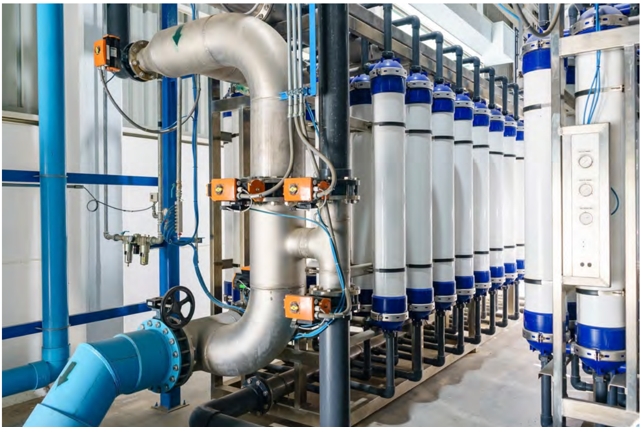
Figura 5. Sistema de pretratamiento mediante cartuchos
