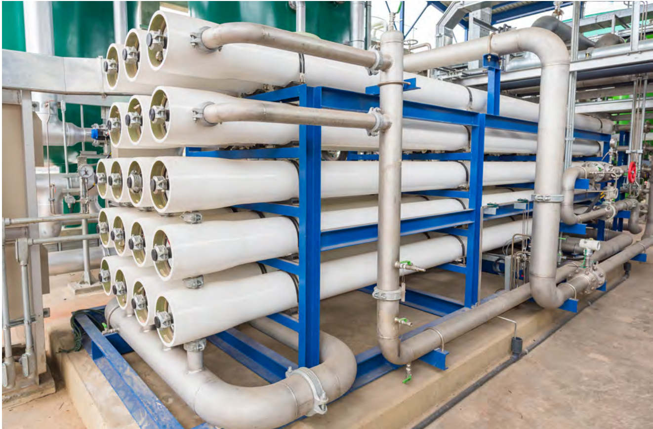
Figura 6. Sistema modular de osmosis inversa
